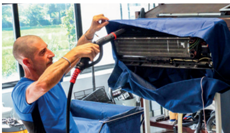
PULIZIA E SANIFICAZIONE DI CONDIZIONATORI
