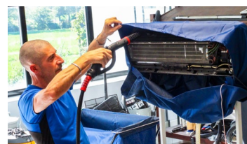
PULIZIA E SANIFICAZIONE DI CONDIZIONATORI
