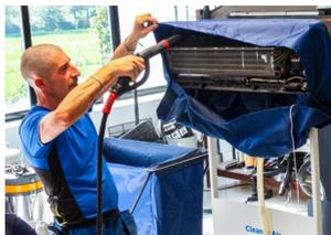
8. Se lo split risulta particolarmente sporco, è possibile sgrassarlo a fondo con il vapore tramite la lancia vapore MGK04N e poi risciacquare con acqua calda.
