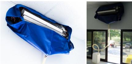
5. Immettere il "detergente enzimatico", correttamente diluito secondo le indicazioni riportate sul prodotto, nello spruzzino. Spruzzare dunque il "detergente enzimatico" sulla batteria dello scambiatore dello split, su tutte le parti in plastica e in alluminio da pulire. Lasciare agire il detergente per 1 minuto.
