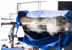
10. Eseguire un nuovo passaggio di vapore sullo split e su tutte le sue parti. La procedura di sanificazione è così terminata, riattivare la corrente elettrica dello split.
