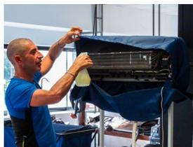
6. Nel frattempo, dentro la vasca a pavimento, procedere alla pulizia della carcassa e dei filtri dello split tramite la lancia ad acqua MGK04AS. Per la pulizia dei filtri utilizzare solo acqua fredda, poiché l'acqua calda farebbe raggrumare la polvere rendendo più lunga l'operazione di lavaggio.
