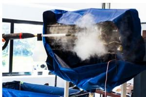
11. Mantenendo posizionata la sacca di lavaggio split, accendere il climatizzatore in modalità ventilazione fino ad eliminare i residui di acqua depositati sulla ventola e sullo scambiatore.
